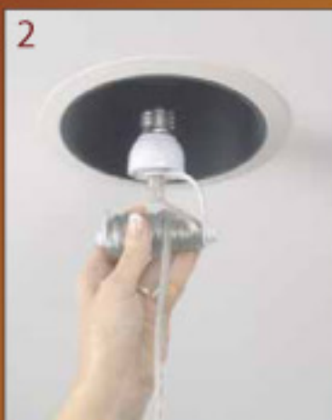
2 Screw in conversion fixture. Enrosque el accesorio de conversión.
